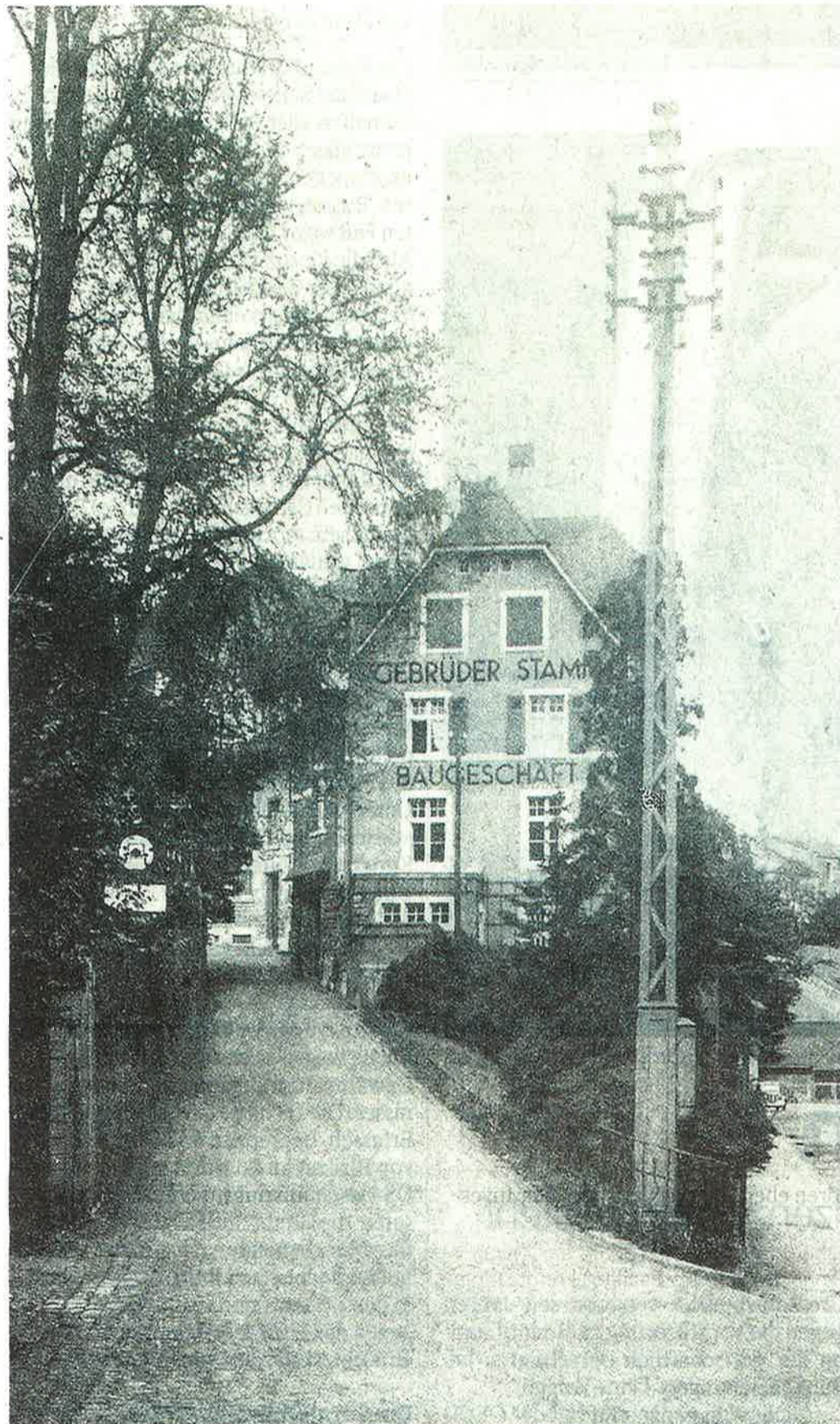
Der Hasenberg. Das Gebäude an der Holbeinstrasse in Basel war von 1913 bis 1943 Firmensitz des Baugeschäfts der Gebrüder Stamm. Archiv Stamm Bau AG
