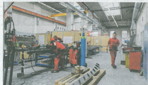
Denkmalschutzgerecht: Die neue Arbeitshalle.
