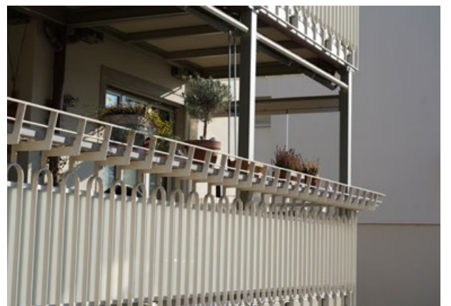
Bei den Geländern wurden Halterungen für Blumenkisten integriert.
