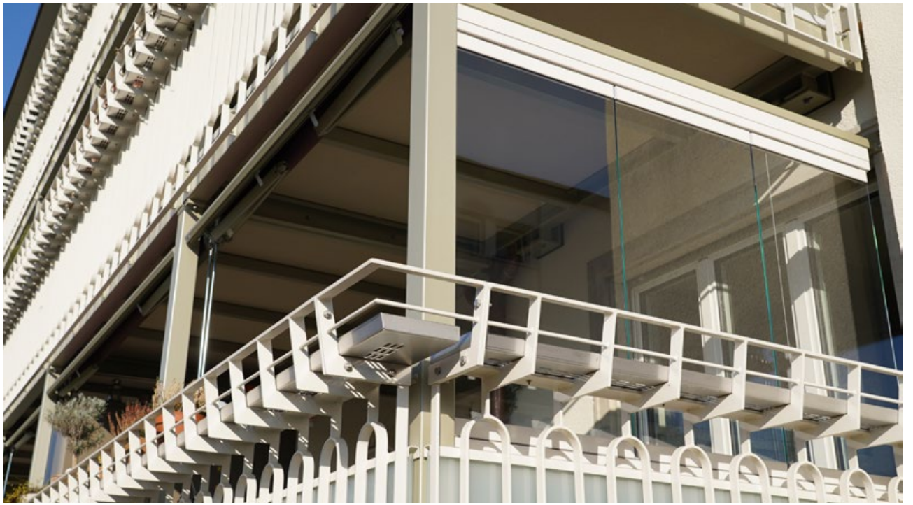
Die Seitenwände der äusseren Balkone schützen vor Wind und Regen.
