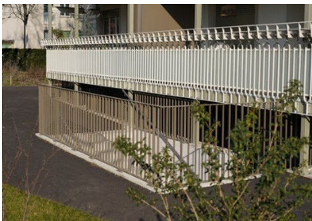
Die Kellerabgänge fügen sich in das neue Gesamtbild ein.
