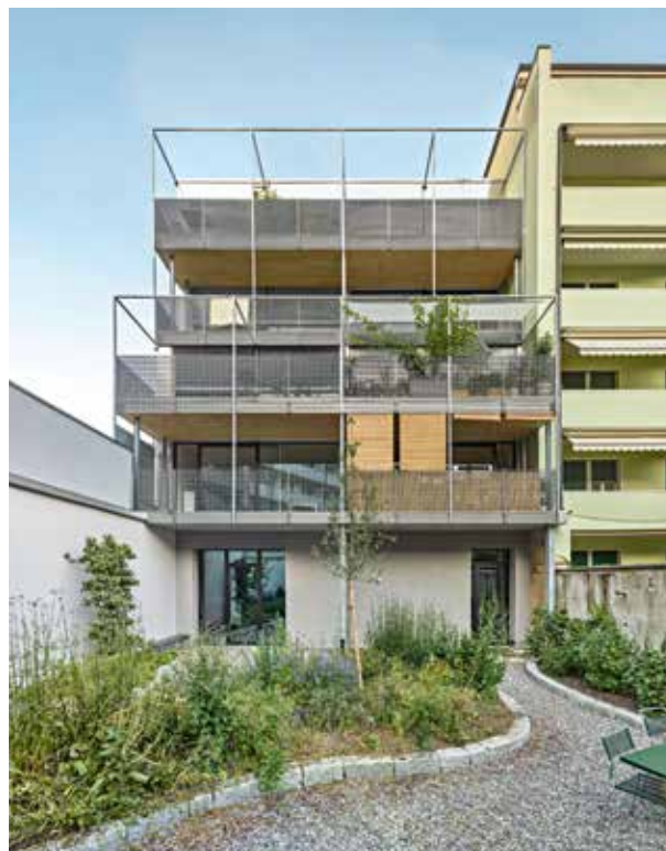
Eine Stahlbaukonstruktion mit Absturz-sicherung aus industriellen Pressrosten fasst die privaten Aussenräume ein.
