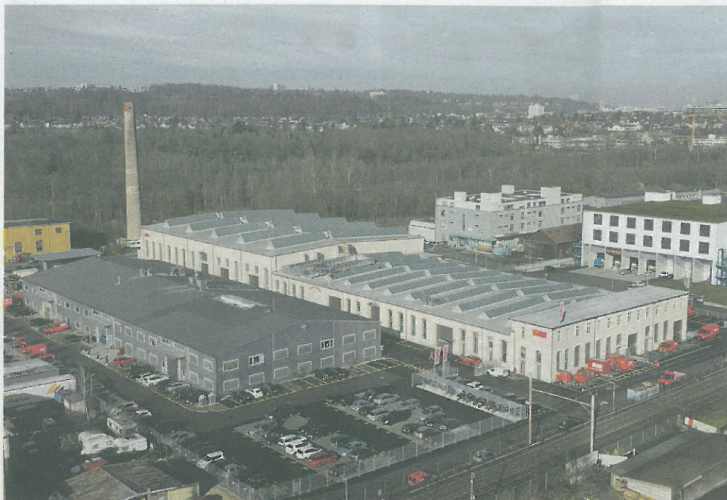
In neuem Glanz: Die Stamm Bau AG hat auf dem früheren BBC-Areal ein neues Zuhause gefunden.
