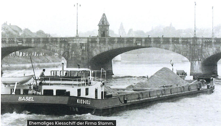
Ehemaliges Kiesschiff der Firma Stamm.
