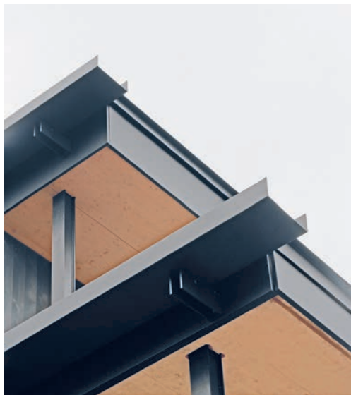
Die breiten Entwässerungsrinnen aus Stahl betonen durch ihre auskragende Form die Abstufelung des Volumens. Unter dem Vordach ist helles Fichtenholz montiert.
