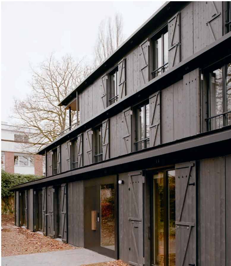
Die wandhohen Schlagläden geben dem Bau etwas Archaisches und spielen mit dem Erscheinungsbild ländlicher Infrastrukturbauten.
