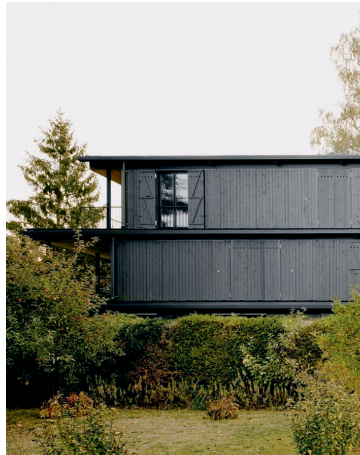
Die schwarz geölte Fichtenschalung kontrastiert zum umgebenden Grün. Das Gebäude verfügt über fünf Wohnungen auf drei Etagen.
