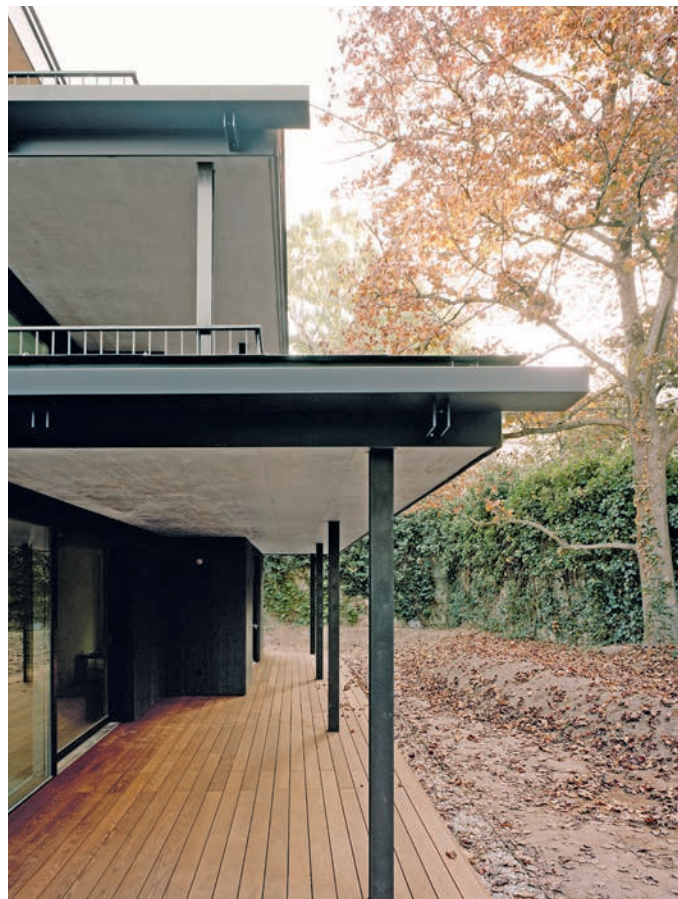
Sämtliche Bau- und Holzbauarbeiten (hier die Terrassenböden) wurden von der Stamm Bau AG aus Arlesheim (BL) durchgeführt.
